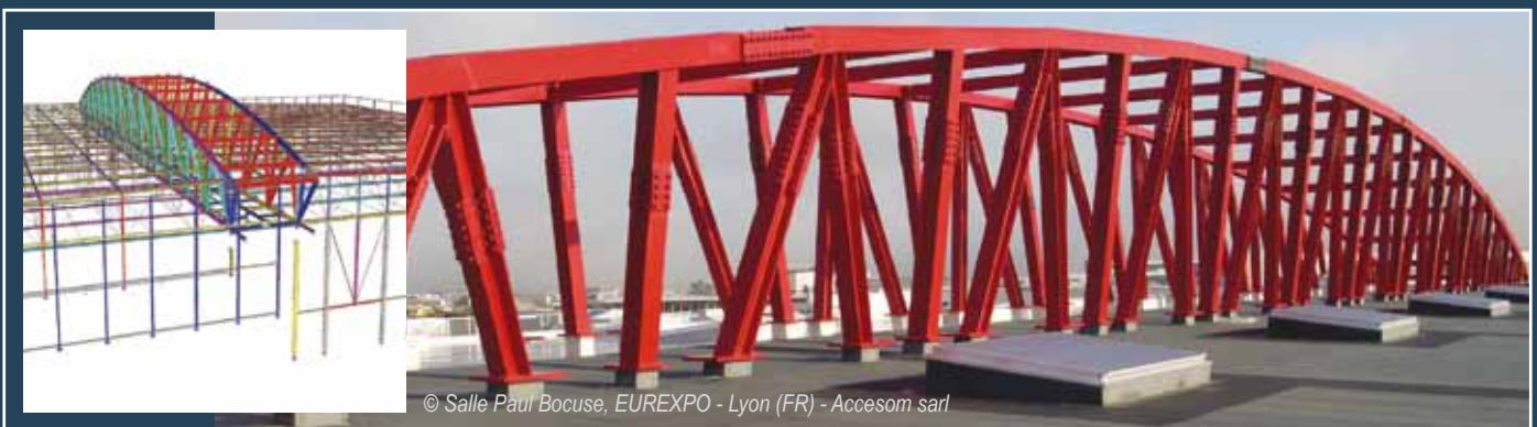
© Couverture de l'atrium, Bâtiment Helios - Saint Jean de Braye (FR) - Baudin Châteauneuf
