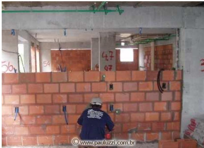
Figura 27 – Alvenaria de vedação racionalizada, detalhe para instalações embutidas
