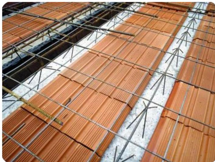
Figura 31 – Laje armada em duas direções
