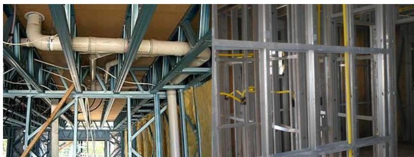
Figura 21 – Instalações Hidrossanitárias e Elétricas
